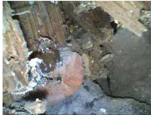
Erkundungsbild einer Hohlraum-Endoskopbefahrung am Übergang Fußschwelle/Kellersockel
