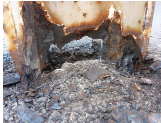
Mechanische Entfernung von korrodierten Querschnittsteilen
