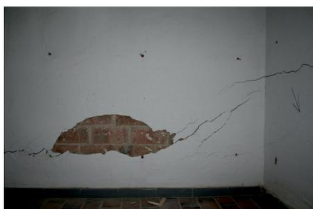
Vertikalverschiebung im DG
