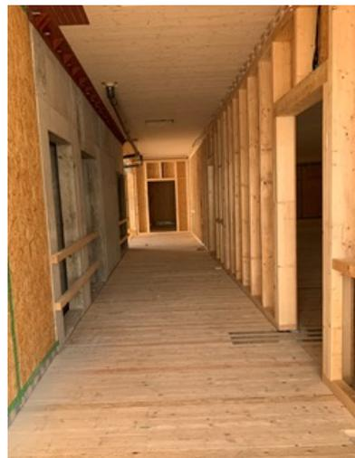
Kernwände aus Stahlbeton restliche Wandkonstruktion in Holzständerbauweise
