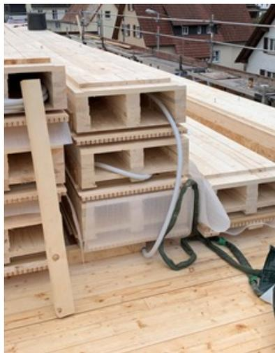
Lignotrend Deckenelemente mit integrierter Akustikdecke und fertiger Oberfläche
