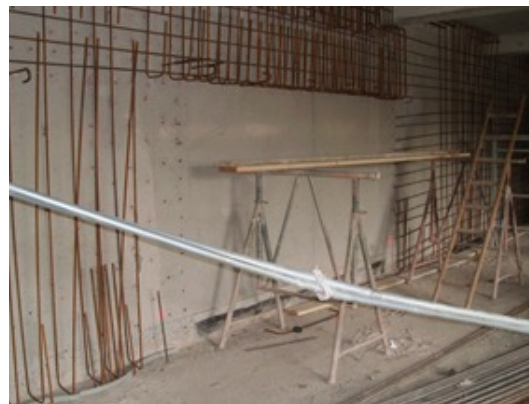
Verstärkung einer freitragenden Wandscheibe um nachträglich Öffnungen für zusätzliche Fluchtwege zu schaffen
