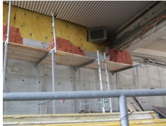
Sanierte Aussteifungswand nach der Betonage mit schwindfreiem Beton
