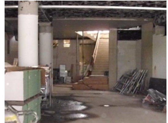
Einbau von zusätzlichen Fluchtwegen / Treppenanlage im Bestandgebäude
