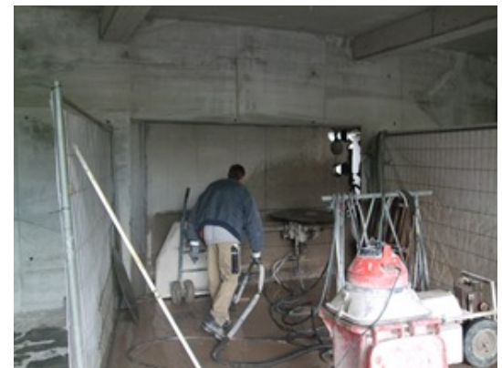
Verstärkte Wand beim Herstellen der Mundlochöffnung
