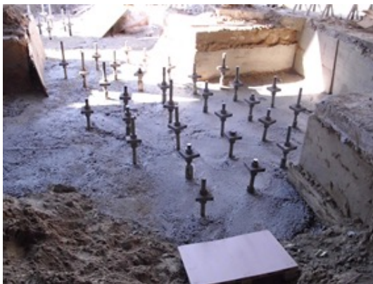
Kleinstbohrpfähle (GEWI) im Gebäudebestand
