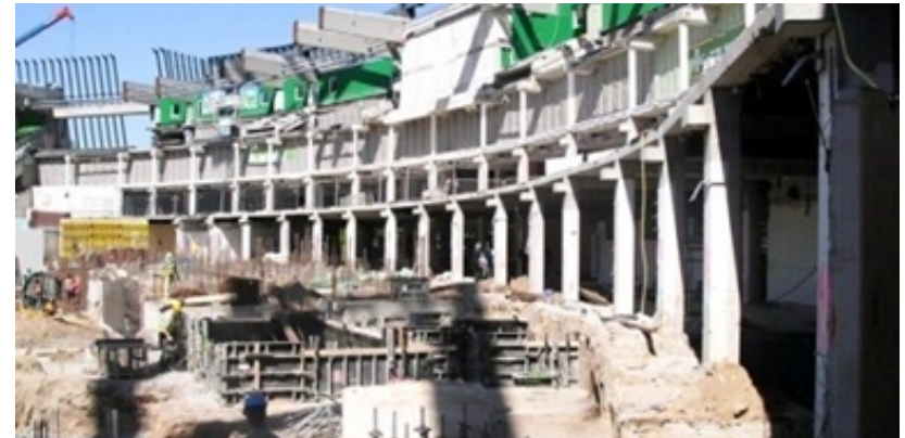
Kleinstbohrpfähle (GEWI) an und im Bestand
