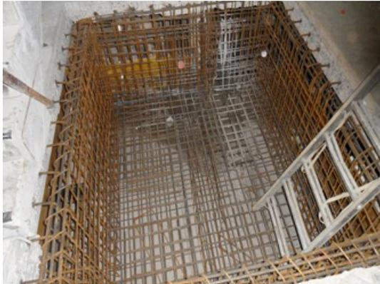
Einbau einer Aufzugsanlage durch Teilabbruch des bestehenden Treppenauges im Bestandsgebäude
