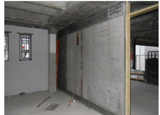
Einbau von Stahlbetonwandscheiben zur Erdbebenaussteifung im Gebäudebestand mittels selbstverdichtendem Beton
