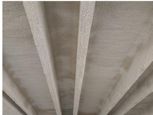
Brandschutzsanierung bestehender Fertigteil PI-Deckenplatten mittels Brandschutzputz
