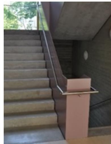
Stahlblechbrüstung an Sichtbetonfertigteiltreppe
