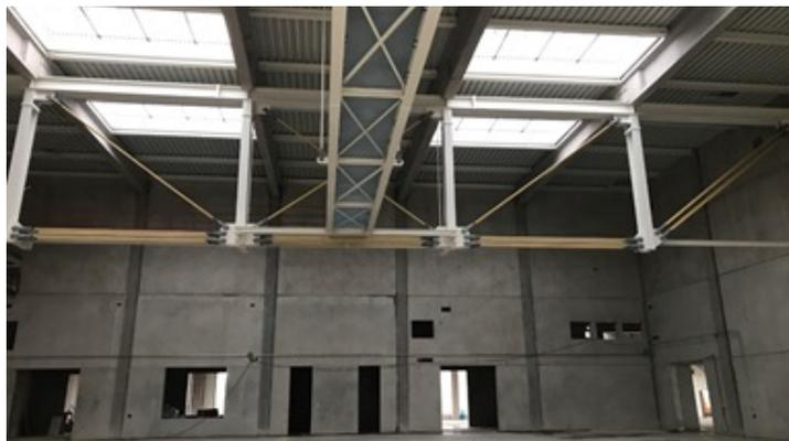
Fachwerkträger 38m Spannweite mit Steg im BT1 im Malsaal
