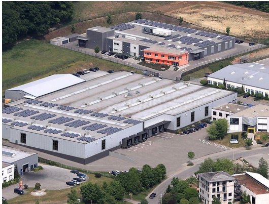
Übersicht Fa. Fells Rotaform in Bretten mit diversen Verwaltungs-, Lager- und Produktionsgebäuden
