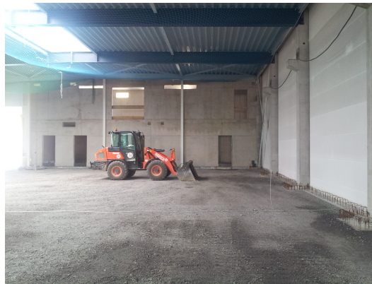
Brandwand mit FT-Stützen und Porenbetonwand im Rohbau
